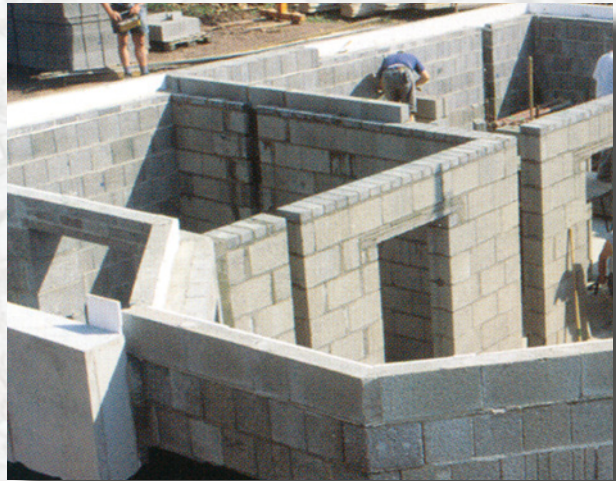
Abb. 6: Kellermauerwerk aus phonolithhaltigen Betonsteinen.
