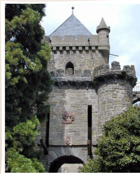
Abb. 3: Löwenburg im Schlosspark Wilhelmshöhe westlich Kassel, erbaut aus einer basaltischen Tuffbrekzie des Habichtswaldes (Foto W. LIEDMANN).
