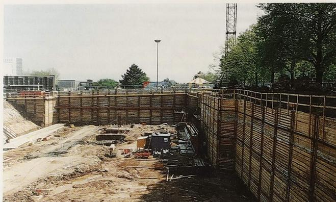
Abb. 25. Baugrubensicherung durch rückverankerte Trägerbohlwand beim Bau einer Tiefgarage in Kassel.
