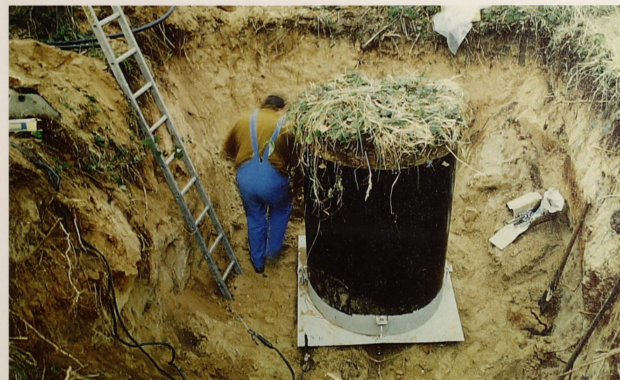
Abb. 7. Einbau eines Lysimeters.
