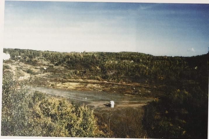
Abb. 33. Grube Messel mit Pumpstation (Bildmitte) und Blick auf die nördliche Grubenböschung mit einzelnen Rutschungskörpern. Im nördlichen Grubenbereich treten die stärksten Bewegungen auf.
