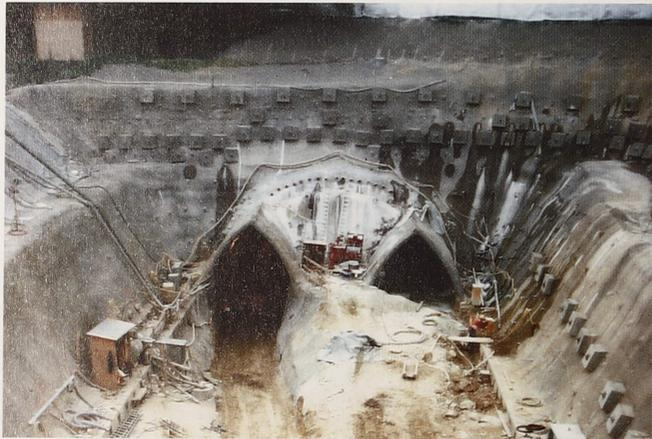
Abb. 14. Tunnelportal Niederrhausen-Nord der ICE-Neubaustrecke Köln-Rhein/Main, das in wasserführenden Lockergesteinen (steinerne Fließerdien über Saprolith) angelegt ist und damit aufwendige Sicherungsmaßnahmen mit zahlreichen Spezialankern notwendig macht. Der Vortrieb der Kalotte ist dreigeteilt in zwei randliche Ulmen und den zentralen Firststollen.
