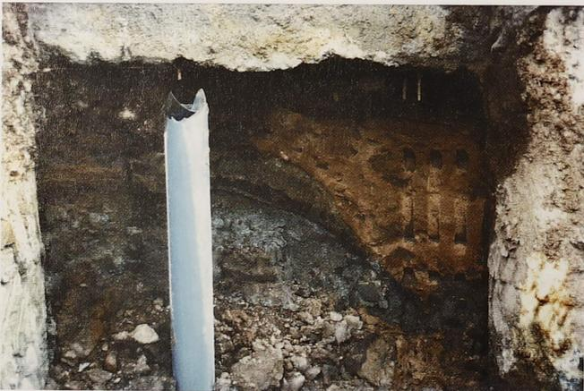
Abb. 15. Typischer Aufschluss an der ICE-Neubaustrecke Köln-Rhein/Main zwischen zwei Bohrpfeilern in der Baugrube Tunnel Wandersmann-Süd südlich der A66 bei Wallau: Quartäre Deckschichten (ockerbraun) des vormaligen Wickerbaches haben sich in die tertiären Tone aus dem Grenzbezug Unterer Rupelton (schwarzdunkelbraun)/Obere Pechelbronn-Schichten (blaugrün) rinnenförmig eingeschnitten. Im Vordergrund ein Brunnen zur Wasserhaltung in der Baugrube (blau).
