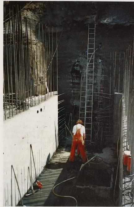
Abb. 32. Bild von den Injektionsarbeiten im rechten Hang der Staustufe Affoldern.
