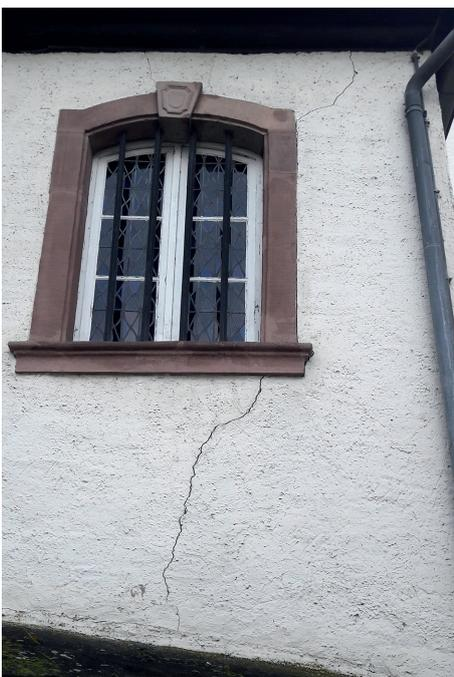
Setzungsschäden an einer Hauswand
