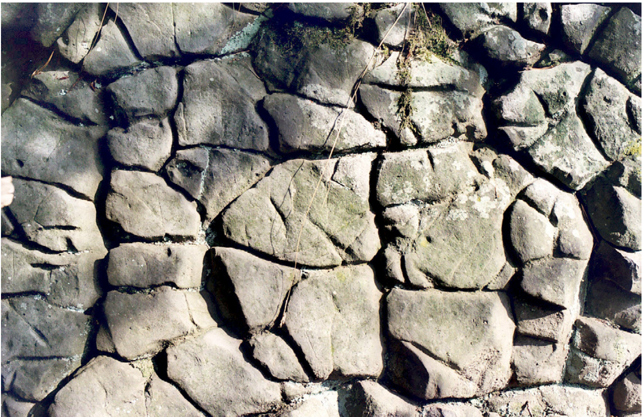
Die Köpfe der Säulen sind sehr unregelmäßig geformt; Die Idealform der 6-Ecke ist nicht erkennbar. Dafür wird deutlich, wie durch weiteres Verzweigen der Kluftabstand immer enger wurde.
