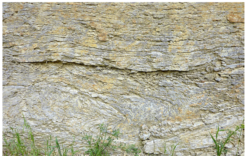
Vermutlich nach seismischer Bodenunruhe ausgelöste Rutschfalte im Wellenkalk.
