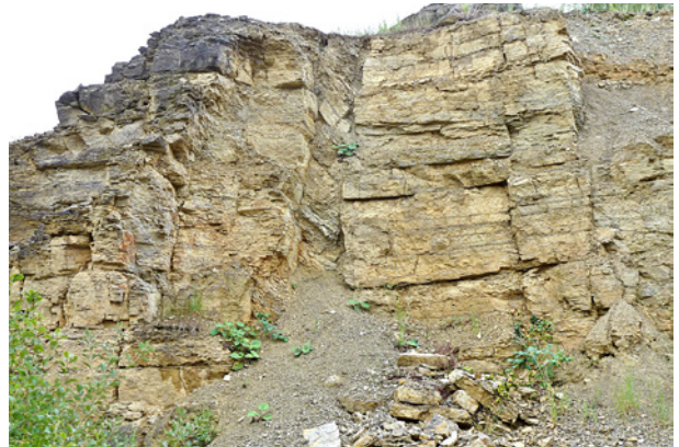
Verkippte Schichten innerhalb einer Störungszone im Wellenkalk [7].
