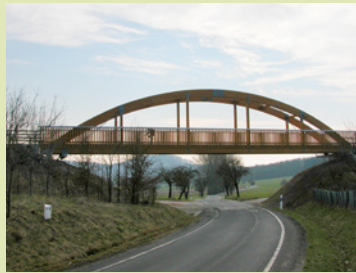
Für den Milseburg-Radweg wurden mehrere Bauwerke, wie diese Brücke, wieder aufgebaut.
