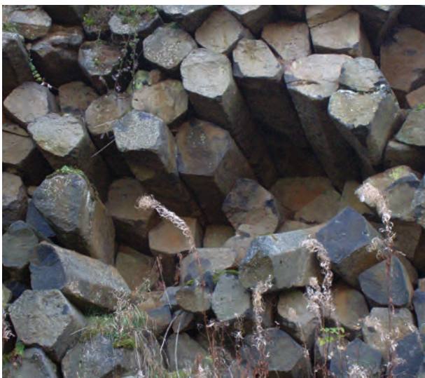
Stillgelegter östlicher Steinbruch Brauerschwend: 20–30 cm dicke Säulen.
