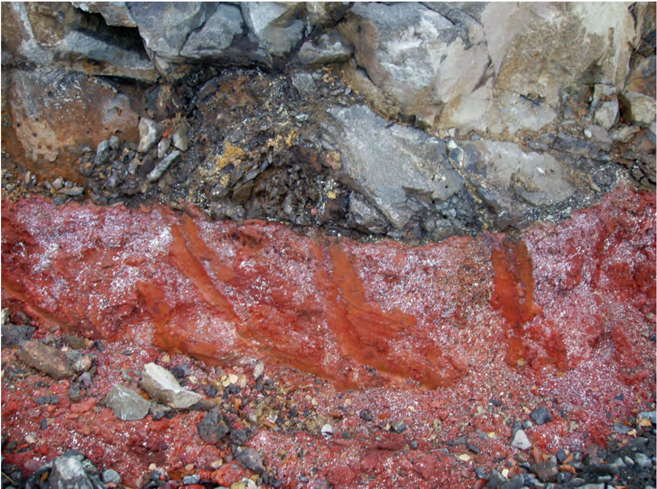
Roter Horizont von verwittertem Material, wahrscheinlich ein basaltischer Tuff. Am Kontakt zur Lava im Hangenden ist er verbacken.
