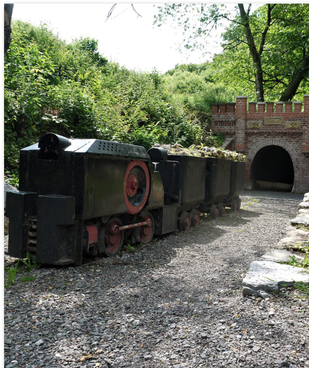
Das Portal des ehem. Mündener Stollens (23) wurde wieder originalgetreu restauriert. Der Stollen selbst ist jedoch nicht zugänglich.
