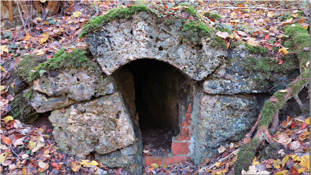
Am Waldrand, von Nentershausen kommend, liegt südlich der Sportplätze und rd. 200-300 m nach dem Vereinsheim des Schäferhundevereins das Portal des ehem. Carlstollens (21) unterhalb eines Waldweges.
