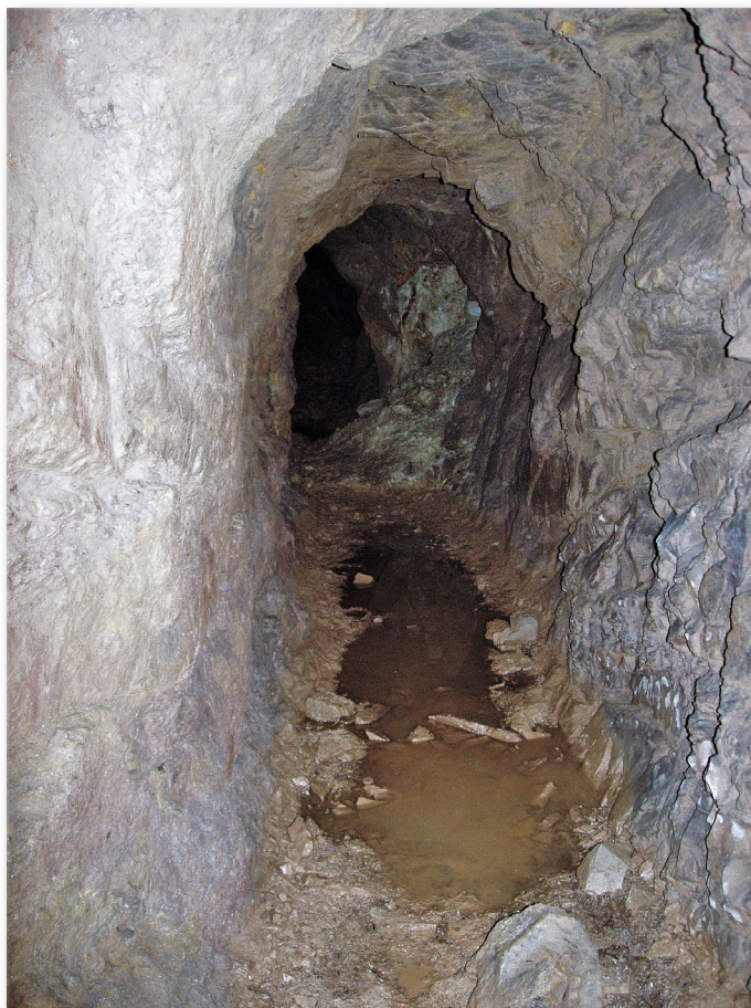
Der Abbau in der Grube Gottessegen (5) folgt dem steil nach SSW einfallenden Schwerspatgang.
