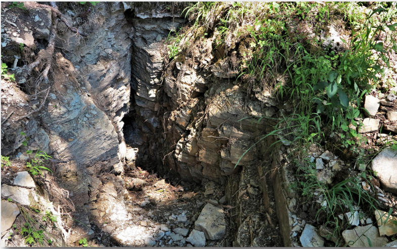
Von den zahlreichen auf der Info-Tafel bei der Rendatalquelle I (6) erwähnten Quellzuläufen ist in Trockenzeiten nur die neben der Tafel, ...
