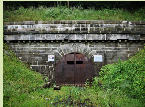
Mehrere Stollenportale wurden in jüngerer Zeit wieder aufwändig restauriert, wie z.B. der Bransroder Stollen, ...
