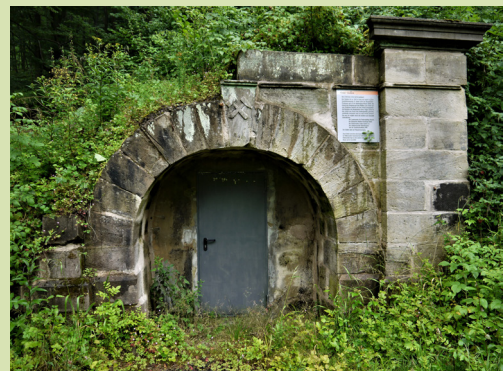
... oder der Neue Stollen (irrtümlich teilweise auch als Wilhelmstollen bezeichnet).
