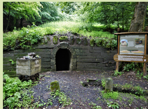
... der Friedrichstollen direkt an der Fahrstraße (L3242, Kohlenstraße) ...
