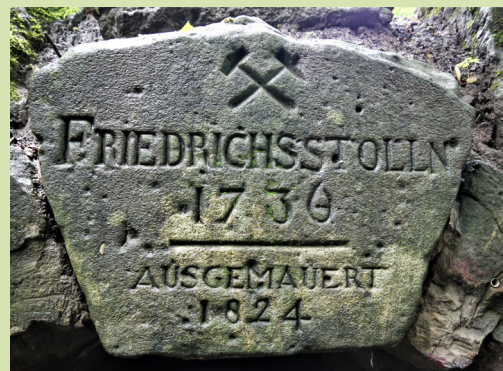
In den Schluss- oder Scheitelstein eines Stollenportals wurden oftmals wichtige betriebliche Daten eingraviert.
