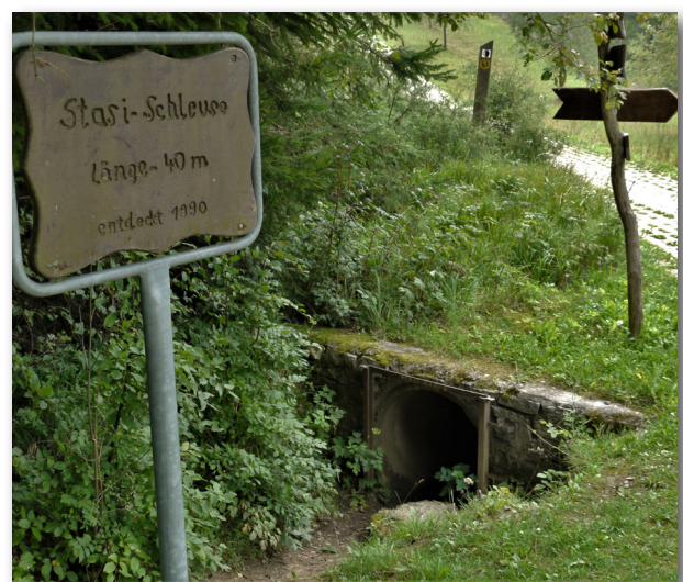
Bei Minen-Räumungsarbeiten im Jahre 1990 wurde ein Röhreneingang entdeckt, der als eine sog. Stasischleuse (10, s. Text) interpretiert wurde.
