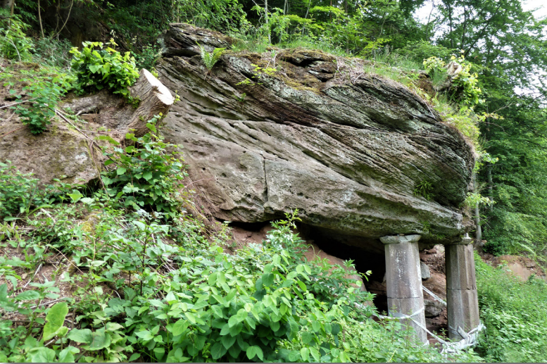
Schräg geschichteter ?Solling-Sandstein (7) mit Felssicherungen ist oberhalb der B27 aufgeschlossen.
