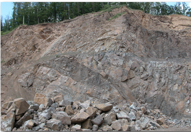
53 Steinbruch Schaffhof, Berkatal-Franksershausen
