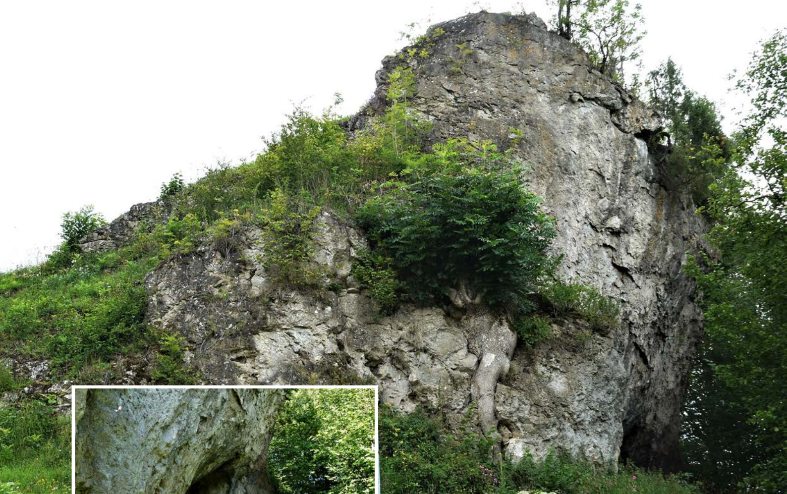
Das etwa 10 m hohe ND Mühlstein (3) besteht aus massivem, brekziösem, meist grauem Plattendolomit (zLCA); vom Hauptdolomit (zSCA) ist er manchmal nur schlecht zu unterscheiden.
