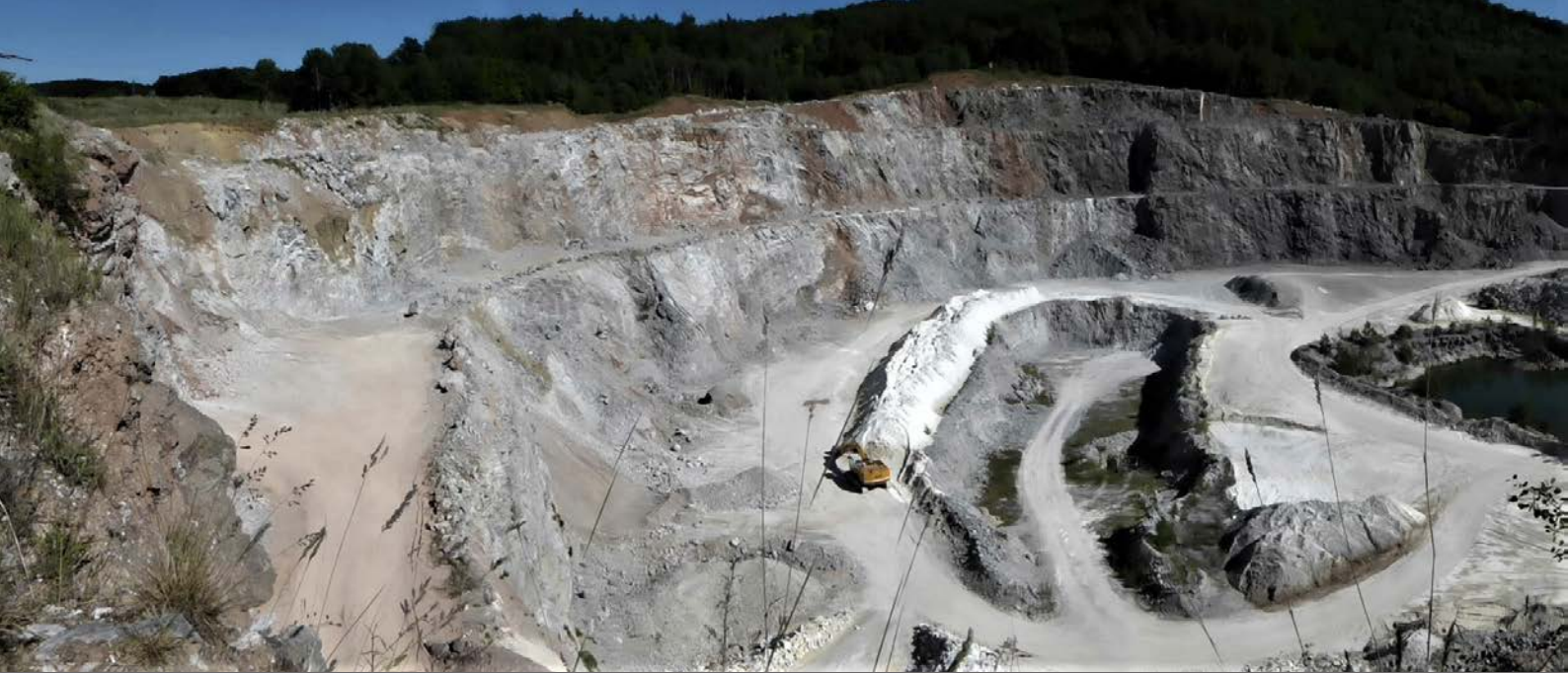
An der Info-Tafel des Geo-/Panoramaweges ( 12 ) bietet sich ein guter Überblick über den Steinbruch. Eine geologische Karte versucht hier die schwierigen Verhältnisse zu erklären.
