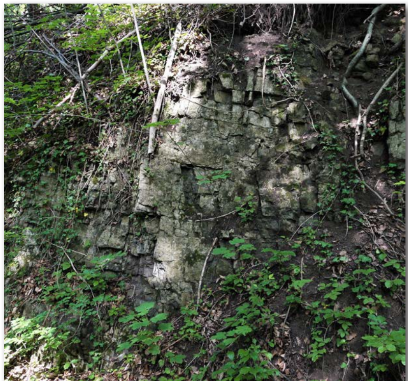
In einer Ruschelzone ( 1 ) erkennbare Schlotten sind mit eingespültem Boden und nachfallendem Sediment gefüllt.
