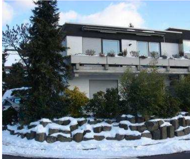
Abb. 6: Verwendung von Basaltsäulen als Hangbefestigung.
