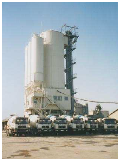
Abb. 13: Transportbetonanlage. Foto: Mitteldeutsche Hartsteinindustrie AG.
