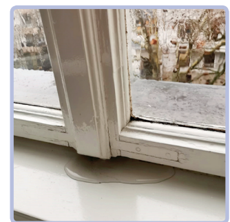
Eindringendes Wasser / Foto: C. Schlitz
