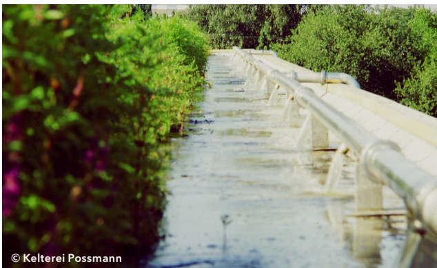
Das zu kühlende Wasser wird am Zulauf des Daches gleichmäßig verteilt.
