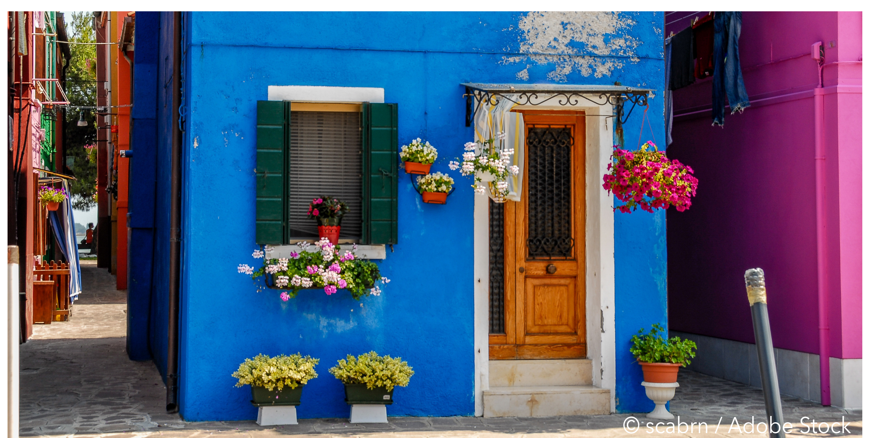
Erhöhte Eingänge schützen vor Überflutungen durch Starkregen
