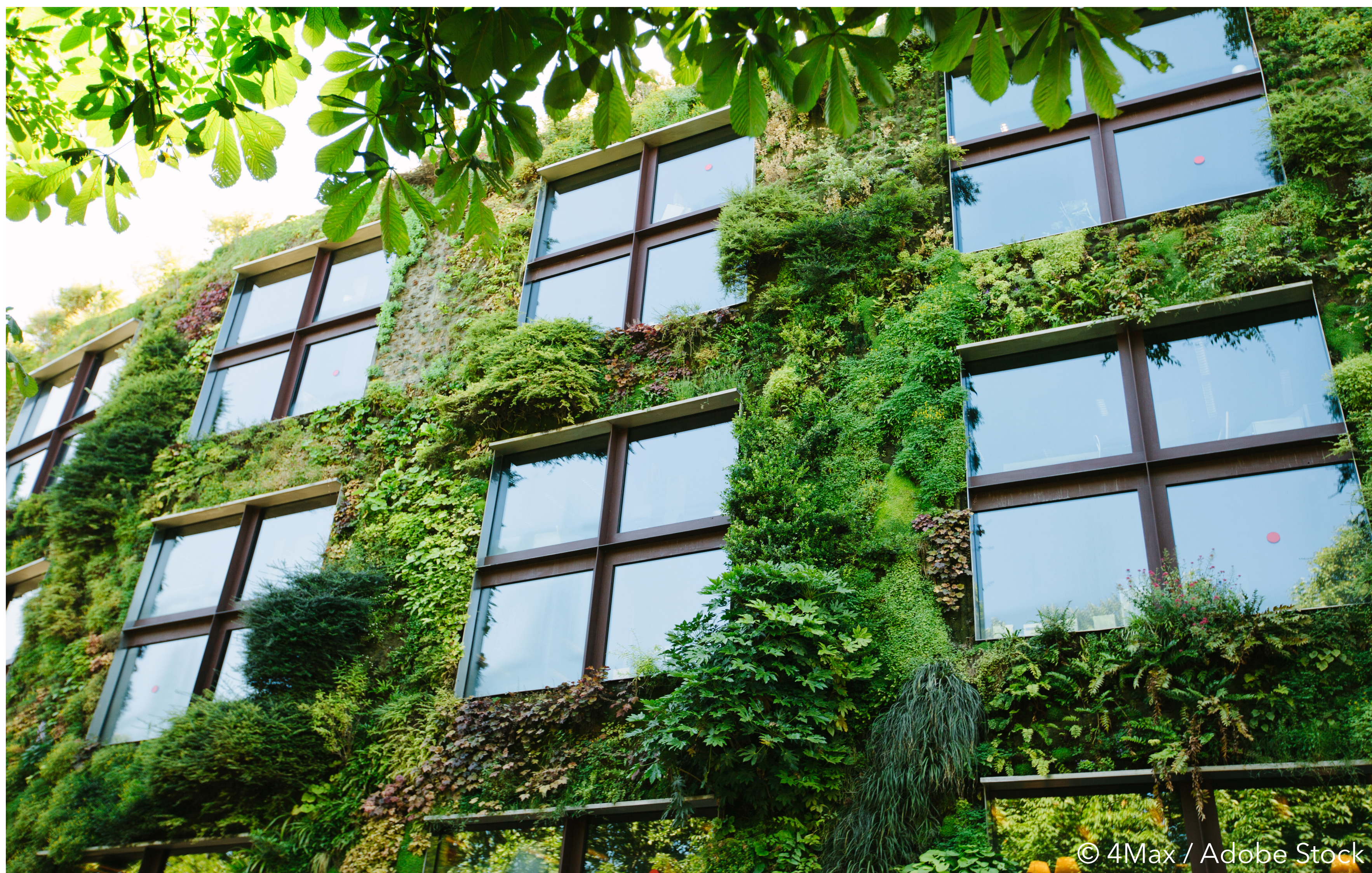
Fassadenbegrünung schützt das Gebäude vorm Aufheizen im Sommer
