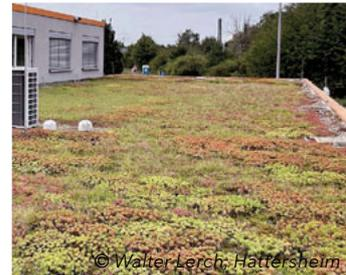
Im Beispiel wurde die Dachbegrünung beim Neubau des Verwaltungsgebäudes vorgesehen. Sie erfordert einen geringen Wartungsaufwand, lediglich zweimal im Jahr müssen größere Wurzeln entfernt werden, um die Dachabdichtung
