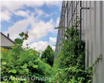
Kletterhilfen an einer 30 m langen und 5,50 m hohen Leichtbaufassade ermöglichen den Bewuchs mit Pflanzen. Die Kletterhilfen wurden beim Herstellen der Wände angebracht. Eine Dachbegrünung, z. B. mit Sedumarten, ist auch bei Leichtbauweise kein Problem.
