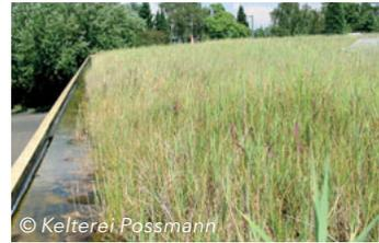
Dachbegrünung kann auch zu verfahrenstechnischen Zwecken genutzt werden. Bei dieser Dachbegrünung handelt es sich um kein gewöhnliches Gründach, sondern um ein Retentionsdach, das in den Kühlkreislauf zur Kühlung der Apfelweinkeller integriert ist. Durch diese klimaangepasste Lösung können pro Jahr 6000 € Kühlkosten eingespart werden.
