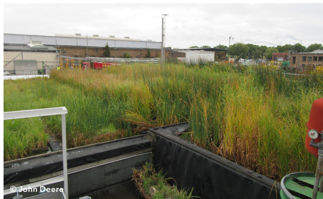
Die Dachpflanzenkläranlage besteht aus immergrünen Schilf- und Seggen-Arten.
