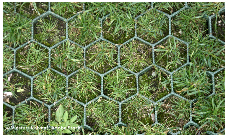
Durchlässige Bodenbeläge können Niederschlagswasser zurückhalten, versickern und das Überflutungsrisiko reduzieren.
