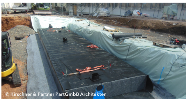
Die noch im Bau befindliche Rigole in Bad Hersfeld wird in Zukunft das anfallende Regenwasser dezentral versickern.
