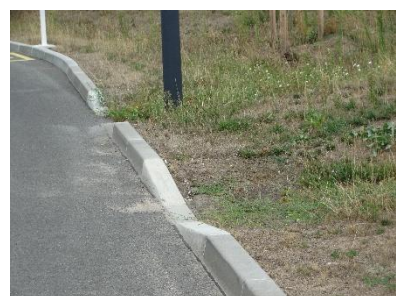
Abbildung 5: Randsteine mit Lücken zur Niederschlagswasserlenkung
