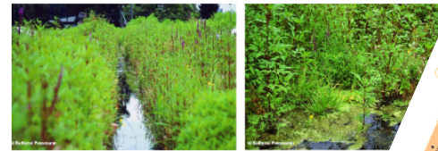
Die Wurzeln der Sumpfpflanzen auf dem Dach stehen ständig in Wasser.
