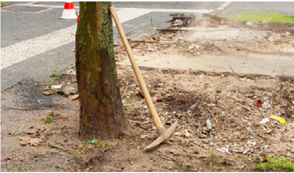
Abb. 20: Die vorbereitenden Arbeiten sind abgeschlossen © HLNUG
