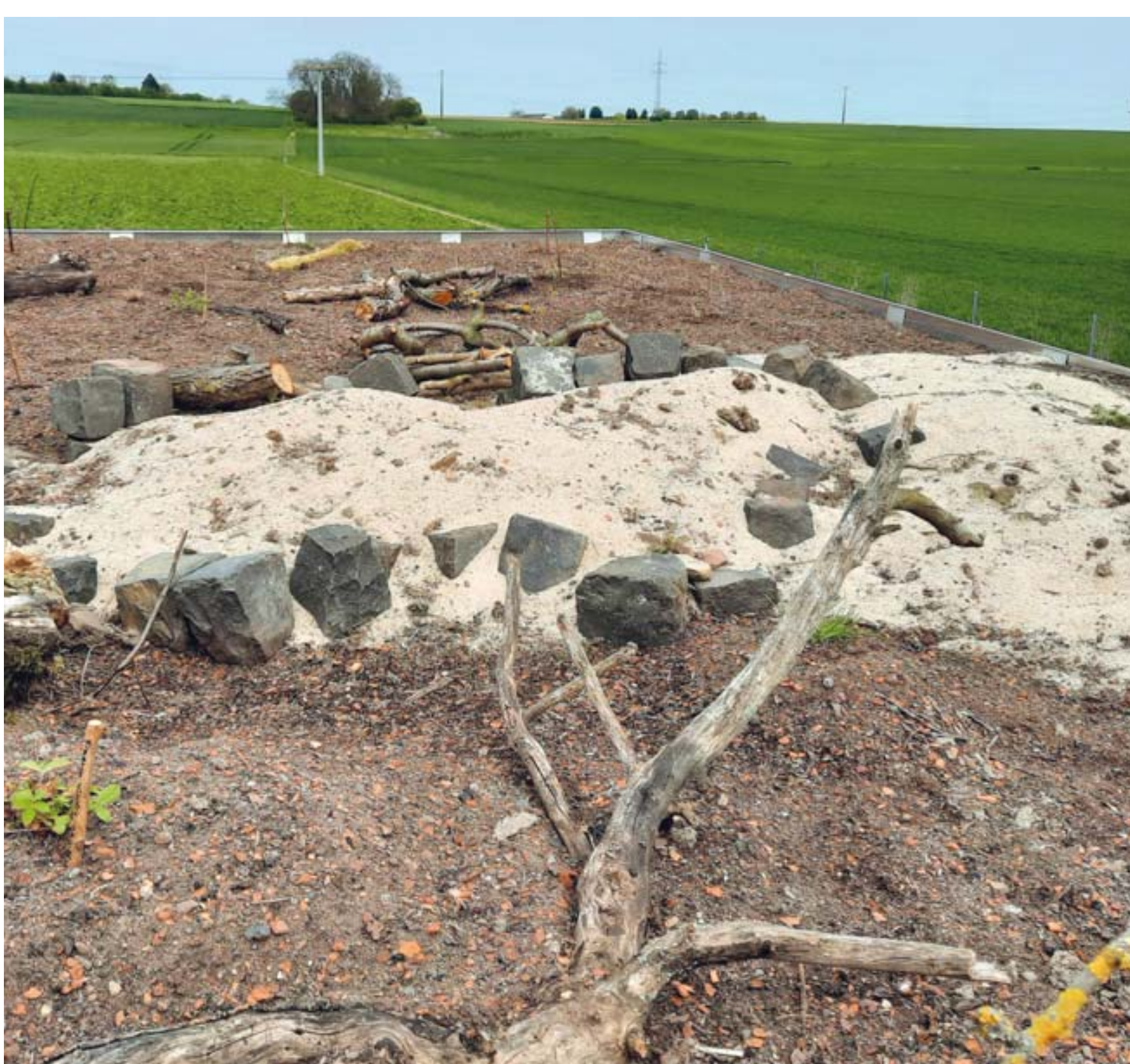
Neuanlage eines Biodiversitätsdaches, Begegnungsgarten Friedberg.
