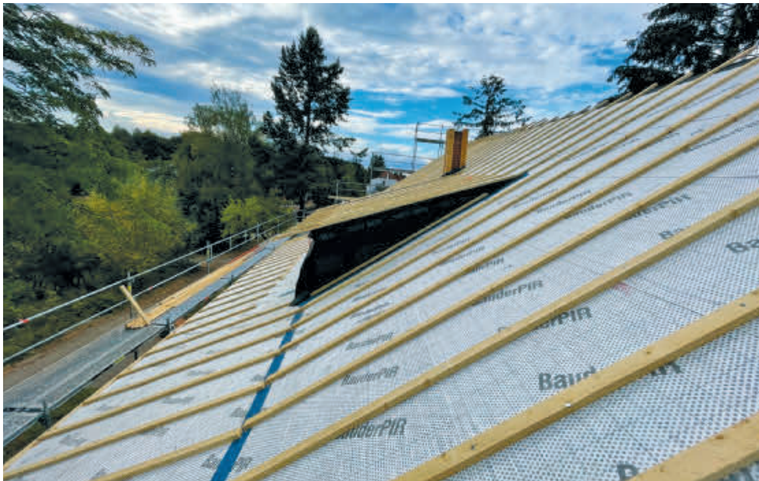
Energetische Dachsanierung / Foto: Sascha Michely
