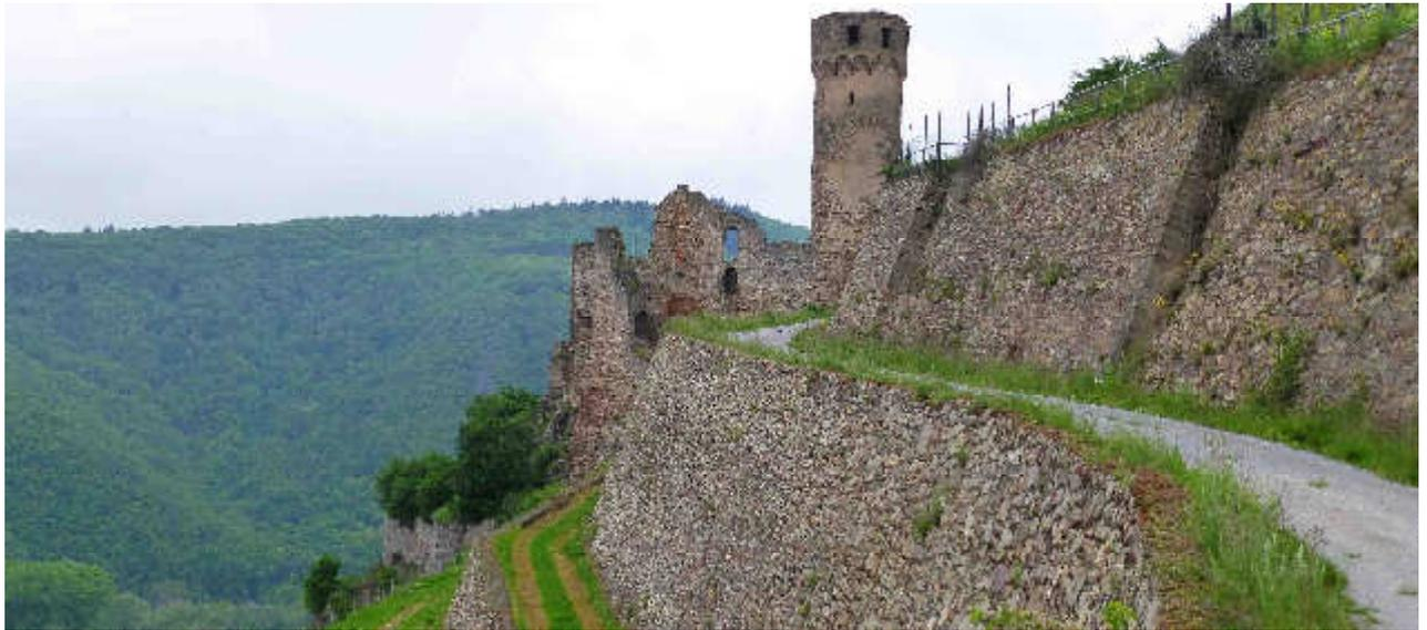
Abb. 9: Hohe, gemauerte Stützwände ermöglichten die Zusammenlegung kleiner Trockenmauer-gestützter Weinterrassen zu steilen Großanlagen, wie hier in der Lage „Schloßberg“. Aufnahme 14.05.2013
