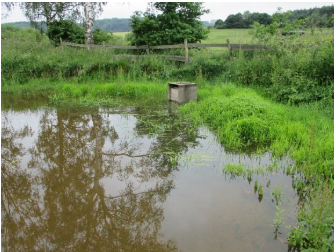
Abbildung 114: Am Mönch bei hohem Wasserstand am 16.06.16
