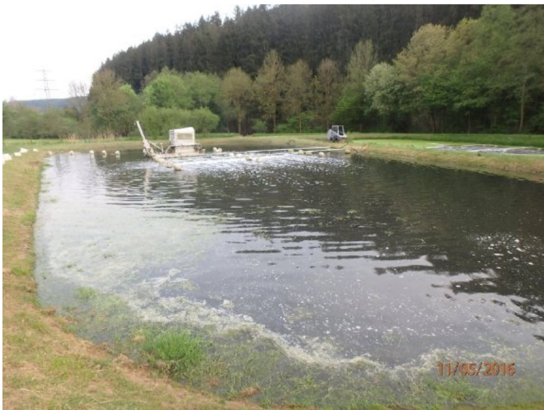
Abbildung 62: Benachbarter Klärteich der Teichkläranlage Hüttenthal
