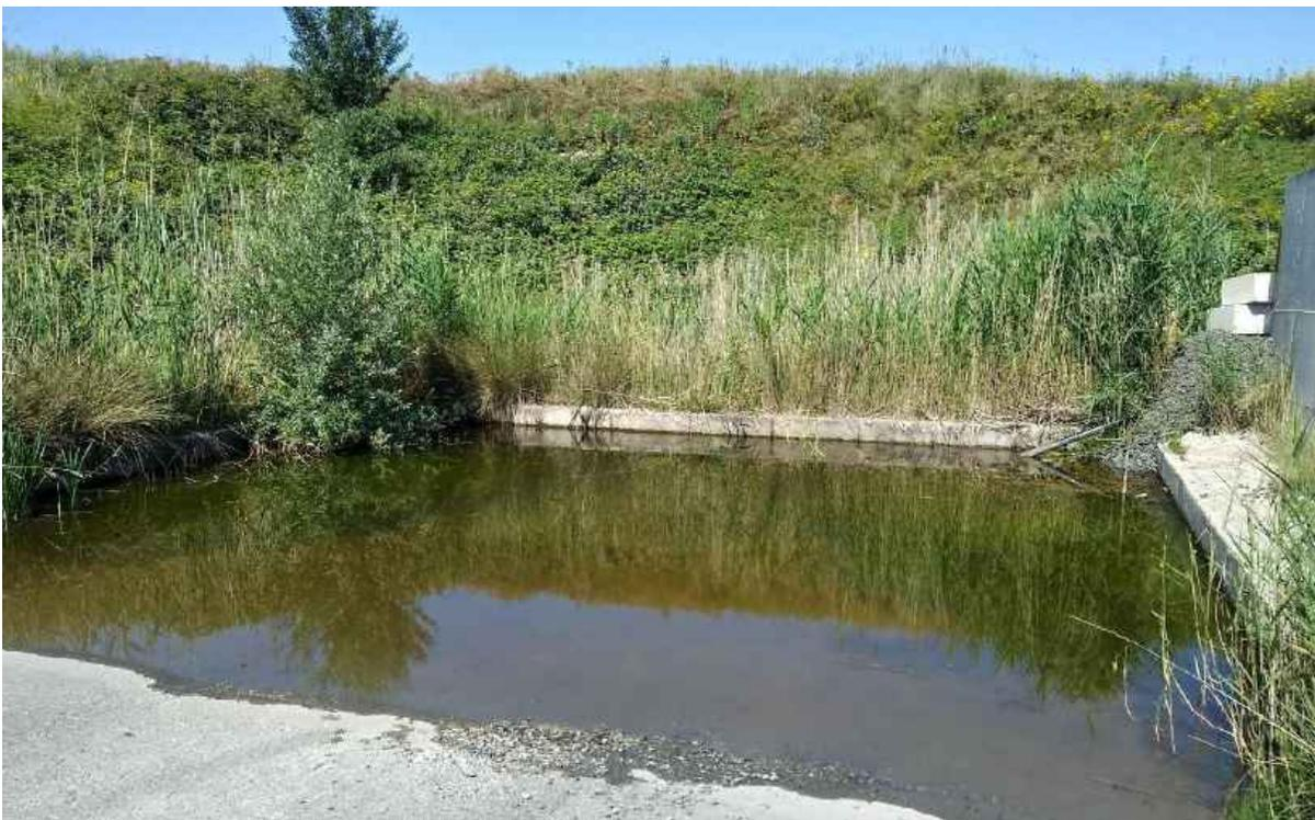
**Abbildung 151:** Auf dem Gelände befinden sich mehrere betonierte Rückhaltebecken (Foto: B. Hill).
