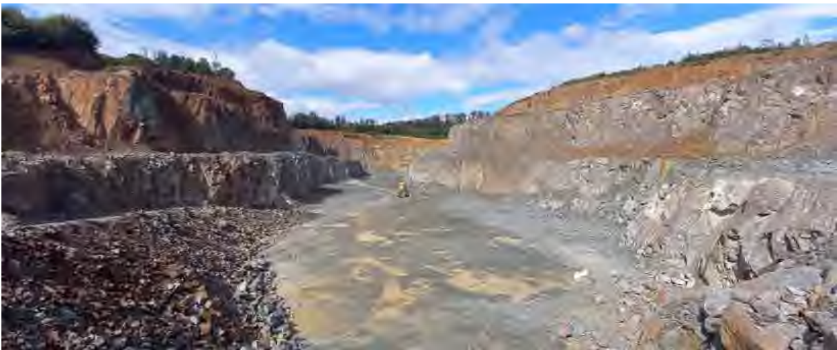
Abbildung 6: Abbausohle im Nordteil des Steinbruchs.
