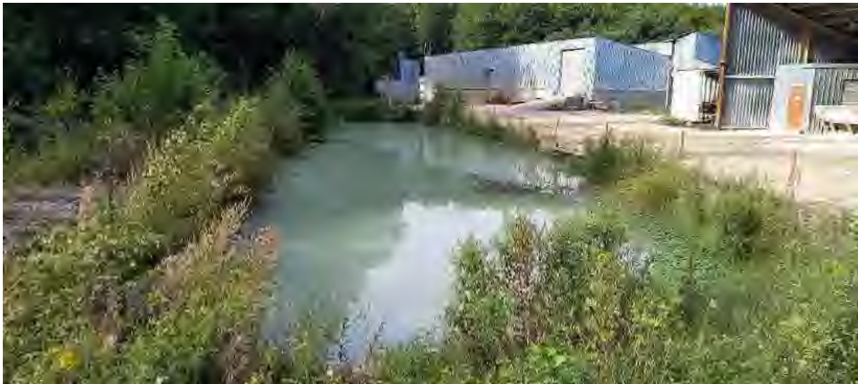
Abbildung 5: Die Rückhaltebecken an der Halle scheinen keine Bedeutung für die GHK zu haben. Foto: R. Polivka, 25.08.2021
