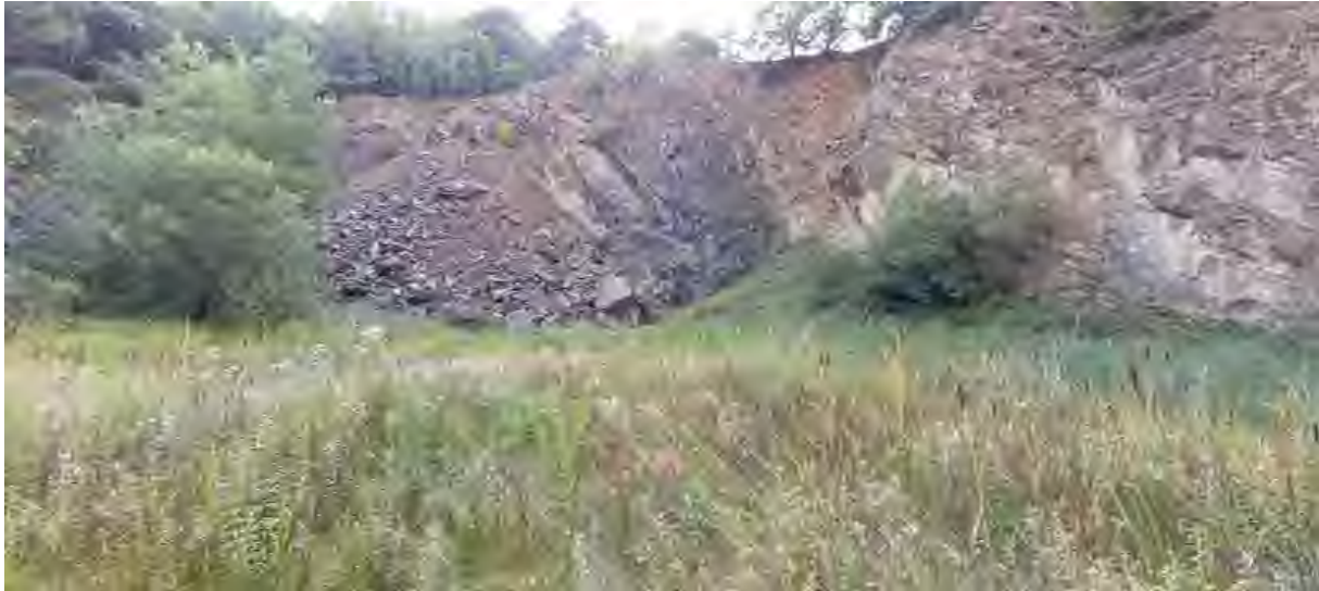
Abbildung 4: Stillgelegtes Steinbruchareal im Westen. Foto: R. Polivka, 31.08.2021
