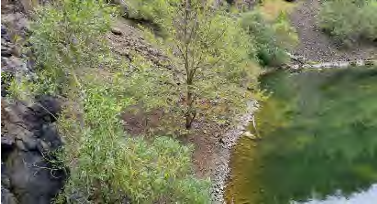
Abbildung 2: Lockeres Gestein und Rohboden im unteren Bereich der Abbruchkante.
