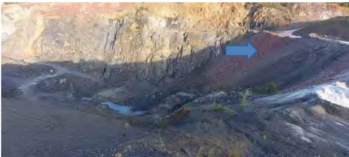
Abbildung 4: Fortschreitende Verfüllung von Südwesten (Pfeil). Foto R. Polivka, 24.08.2021.
