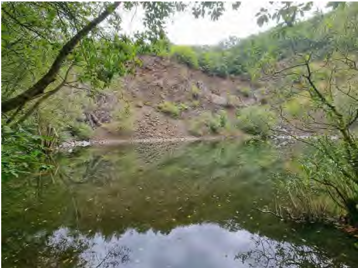
Abbildung 1: Sicht von der Westseite des Gewässers Richtung Abbruchkante.
