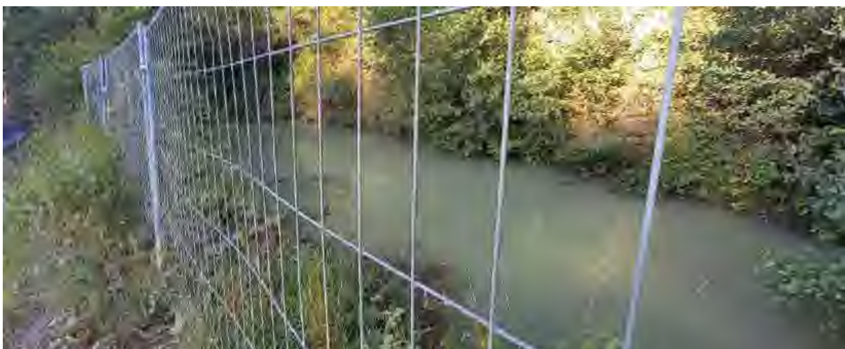
Abbildung 6: Rückhaltebecken an der Straße beim Schotterwerk. Foto R. Polivka, 24.08.2021
