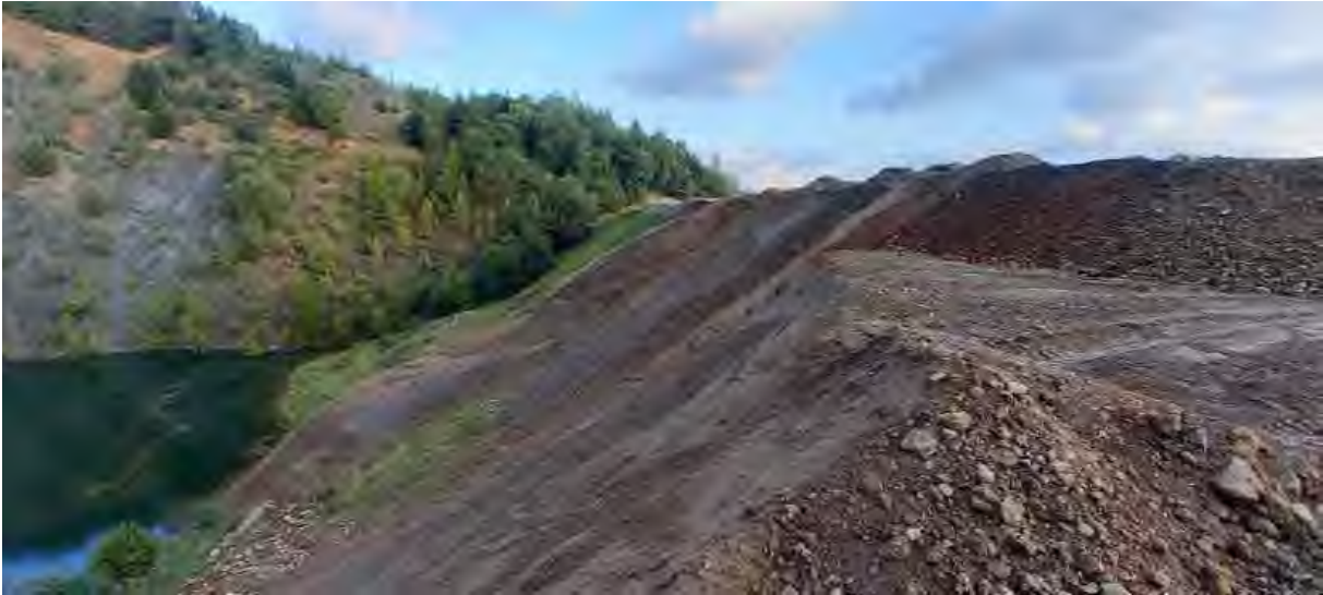
Abbildung 2: Voranschreitende Verfüllung des Steinbruchsees. Foto: R. Polivka, 23.08.21
