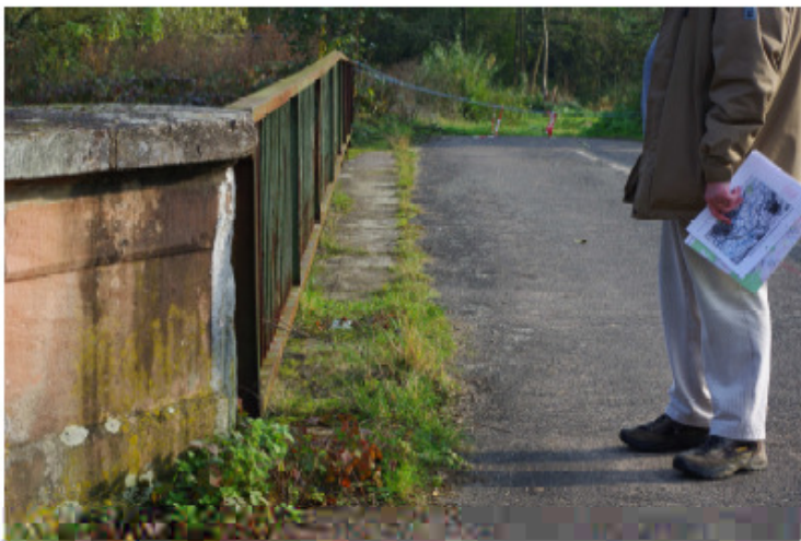
Im Detail: Aufwuchs von Vegetation auf der linken Brückenseite. Hier kann ein Vegetationsstreifen bis zu einem Meter Breite entstehen.
