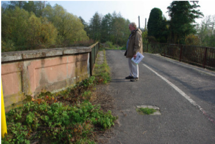
Brücke über die Kinzig. Die Straße mündet am Ende der Brücke in einen Fußweg.
