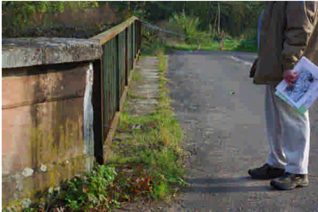
Abb. 47: Aufwuchs von Vegetation auf der linken Brückenseite. Hier kann ein Grünstreifen von bis zu 1 m Breite mit Vernetzungsfunktion entstehen (Foto: M. Demuth-Birkert).
