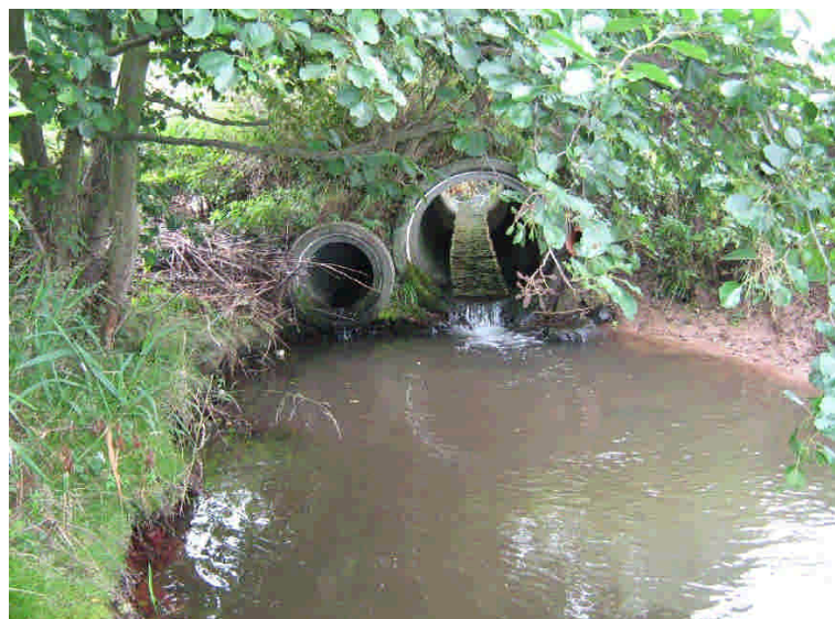
Abbildung 29: In freiem Überfall endende Verrohrung und Kolk am oberen Ende der Probestrecke PS 25
