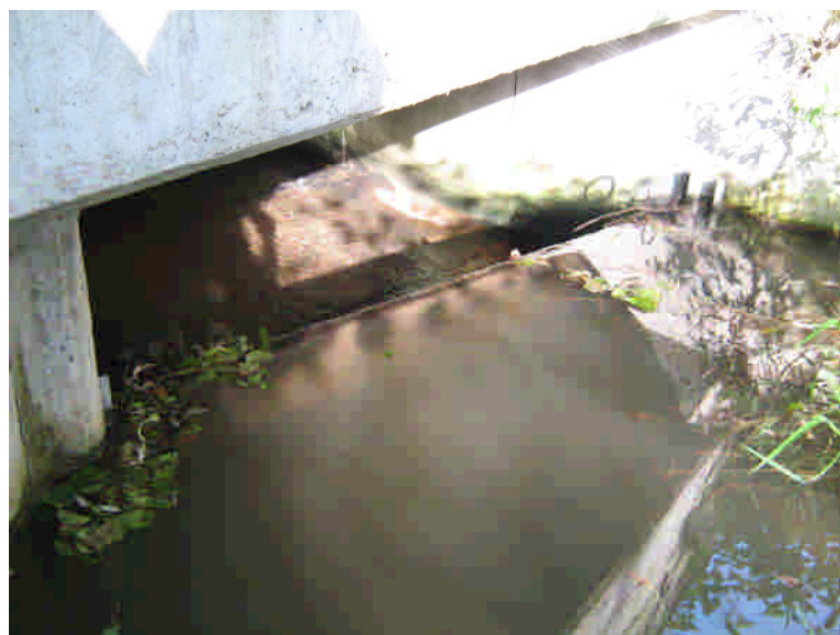
Abbildung 14: Als Aufwanderungshindernis für Fische wirkendes Sperrbauwerk im Heidigsfeldgraben oberhalb der Ortslage Großentaft
