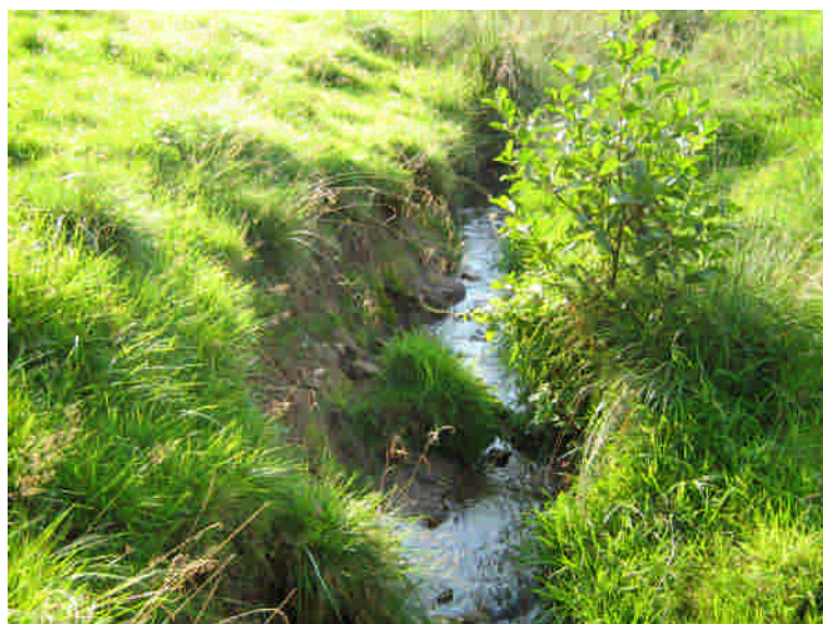
Abbildung 32: Erosionsprofil des Scheppenbaches im Bereich von PS 35
