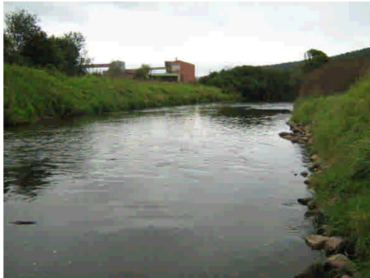
Abbildung 8: In einem Trapezprofil ausgebauter unterste Ulsterabschnitt an PS 1
