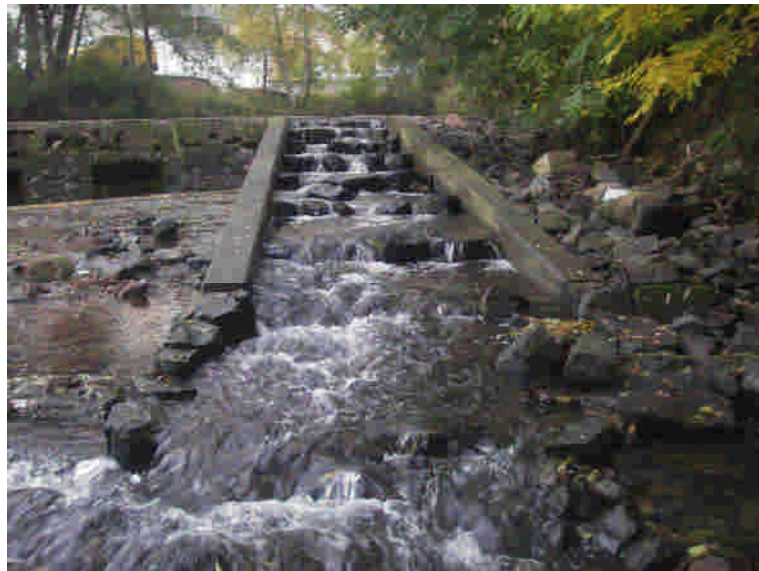
Abbildung 4: Im Jahr 2001 am Wehr der Huhnmühle errichtete Fischtreppe. Aufgrund der engen räumlichen Verhältnisse und der starken Eintiefung der Ulster gegen ihr Vorland wurde eine technisch geprägte Fischaufstiegsanlage errichtet (Photo: Th. Schmidt 2005)
