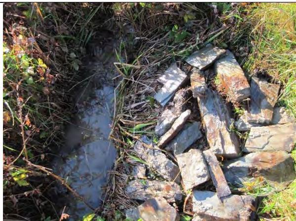
Abbildung 3: Rausgelöster Verbau im Oberlauf des Eibach
