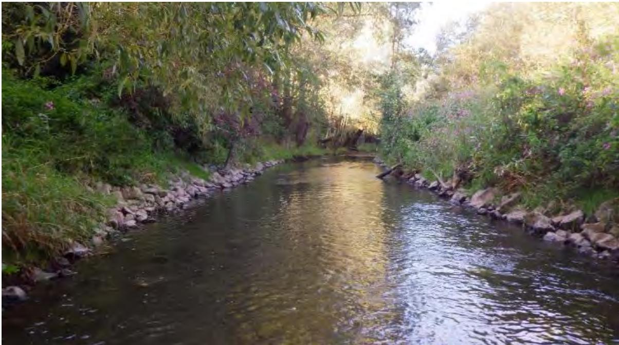
*Abbildung 21: Blocksteinschüttung am Ufer der Ausleitungsstrecke der Haune. C. Dümpelmann, 19.09.2023*
