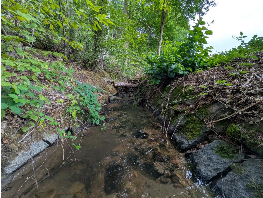
Abbildung 15: Harter Uferverbau am Mumbach in Bereich von Transekt 5. L. Schubert, 26.07.2025
