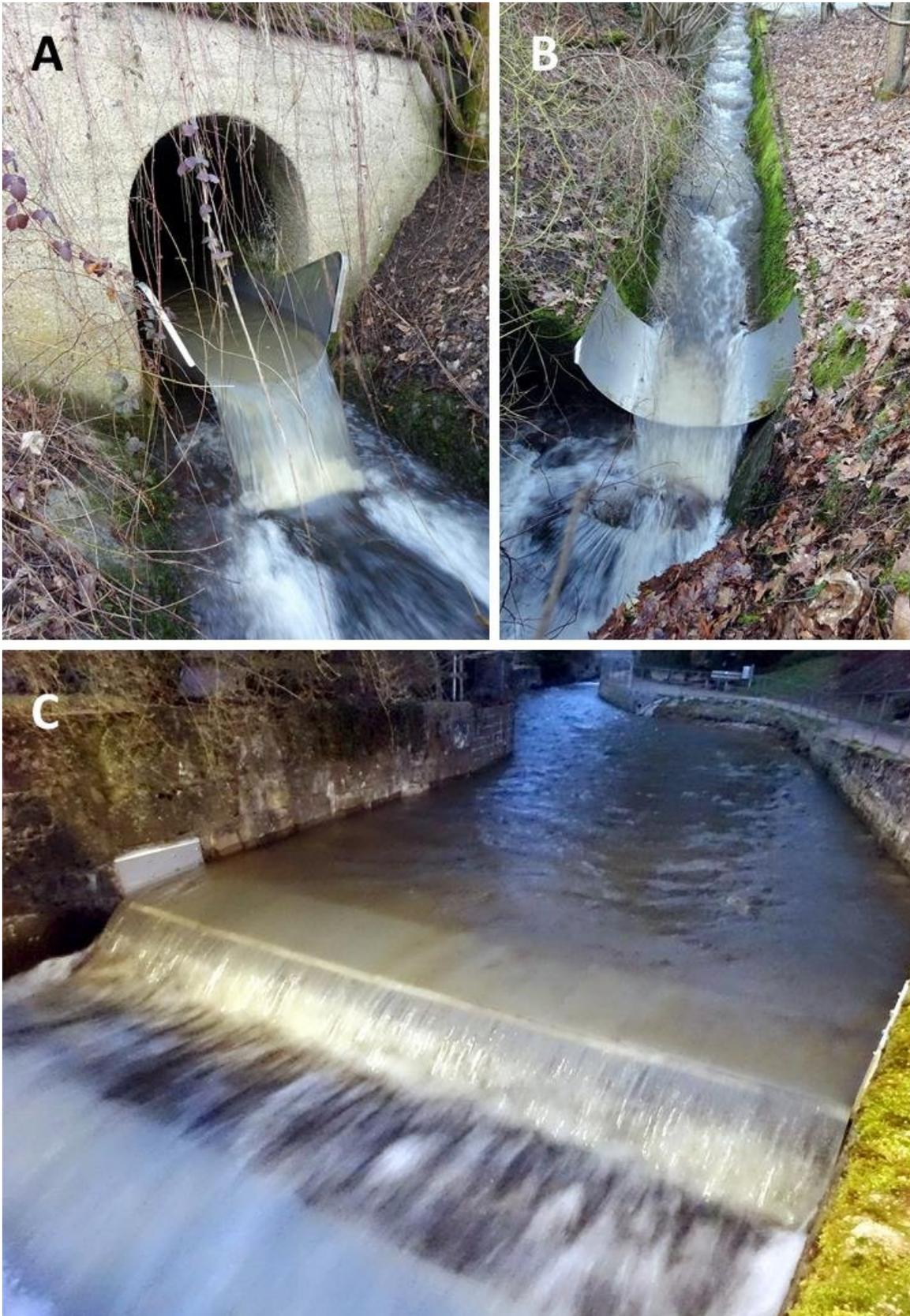
Abbildung 2: Verschiedene Vollsperrn in *ad hoc* Bauweise (A – Finsterbach, BW; B – Zieggraben, BW; und C – Kander, BW). Die Sperrn wurden jeweils auf vorhandene Strukturen aufgesetzt. Für A wurde der Absturz neu erzeugt. © C. Chucholl.
