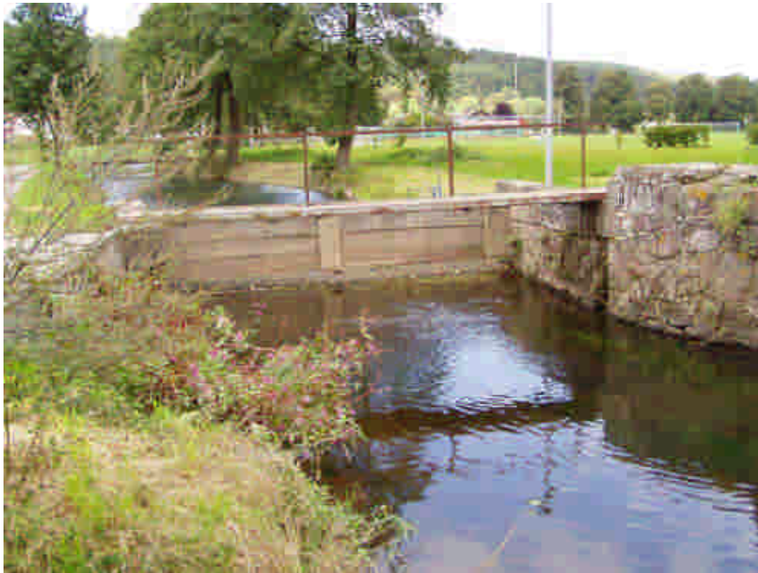
Bild 11: Ein großer Teil des Ederwassers wird am Wehr Viermünden zur Forellenmast abgeleitet und fließt nach dem anschließenden Betreiben einer Wasserkraftanlage ungeklärt in die Eder zurück. (Foto: C. Dümpelmann, 06.09.2007).
