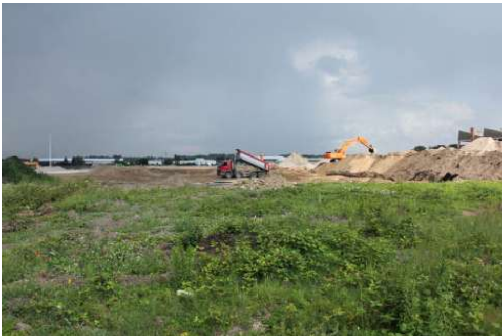
Abb. 1: Bebauung der ehemaligen Monitoringfläche ID 17.
