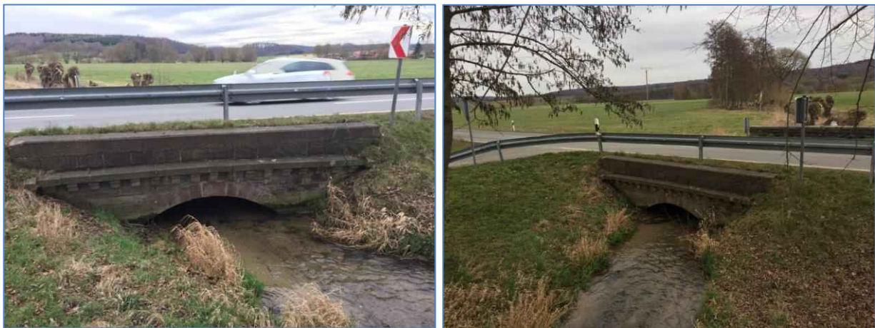
Abb. 39: Gefahrenpunkt am KBW LP-300 über den Wälzer-Bach in Bad Zwesten. Da keinerlei trockenes Ufer unter dem KBW gegeben ist, werden Otter hier verleitet, das Gewässer zu verlassen und über die B485 zu laufen.
