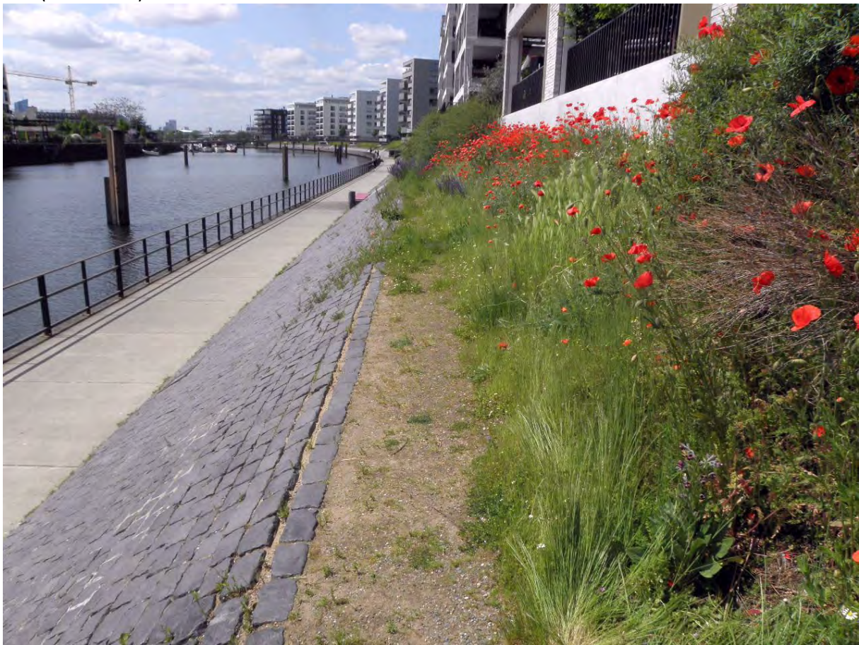
Abb. 3.05.6: Bereich 1 am 17.05.2023. An den mikroklimatisch sehr warmen Zwischenflächen blühen stellenweise viele für Wildbienen attraktive Nahrungspflanzen ( Salvia pratensis , Vicia cracca ). In den Fugen der Pflasterung können Stechimmen nisten.
