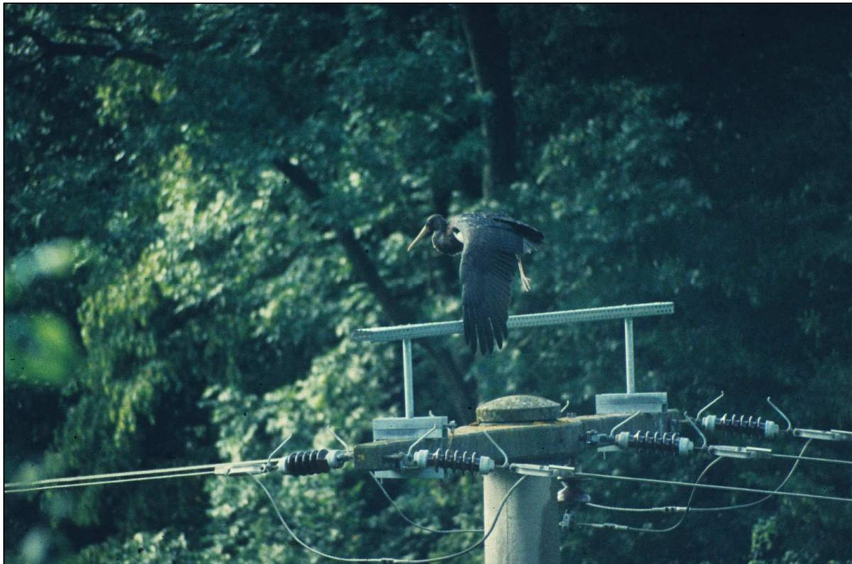
**Abb. 55: Juveniler Schwarzstorch auf gesichertem Leitungsmast – auch bei maximaler Streckung der Flügel ist kein Stromschlag möglich (Archiv VSW).**
