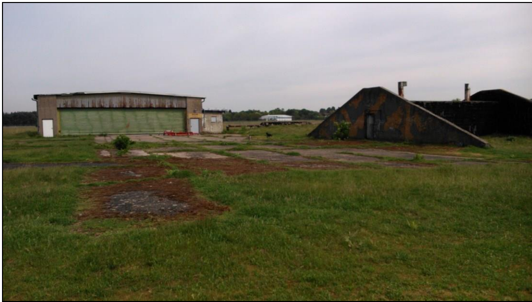
Foto 5: Alte Hangars als (ehemalige) Nisthabitate des Steinschmätzers
