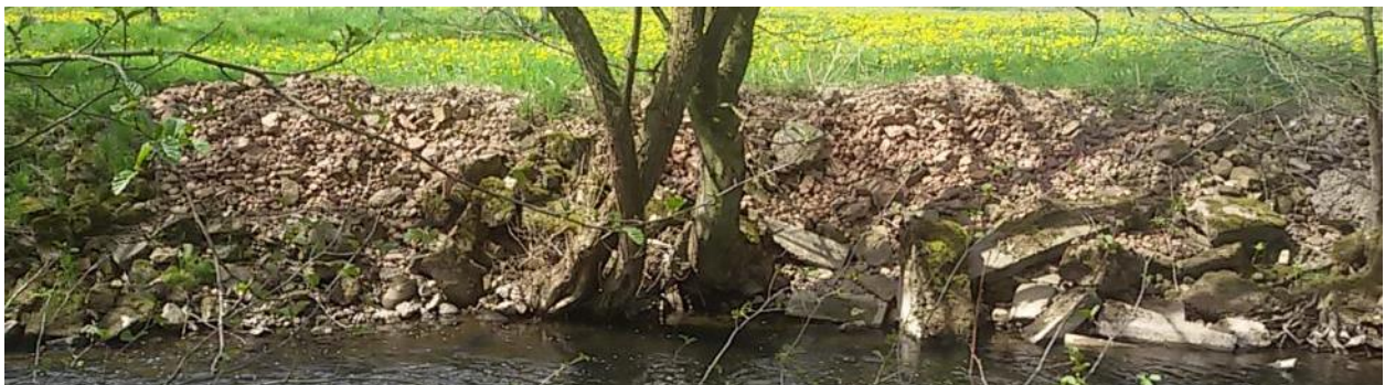
Abb. 5: Uferverschüttung an der Ulster nördlich von Aura; Foto: B. Baumann
